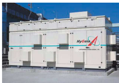
300 m 3 /h アンモニア改質器ユニット (燃焼器用，燃料電池用)
